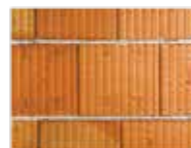
Blocuri ceramice cu locaș de mortar sau N+F.
