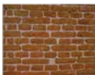
Rost vertical și orizontal de mortar.
